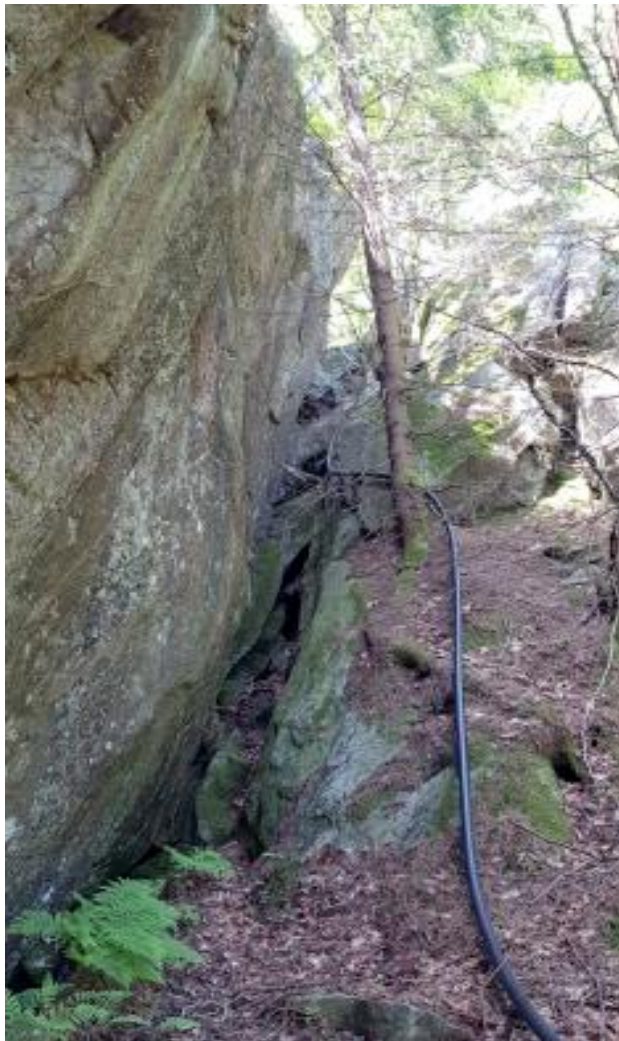
Figur 17: Bergskrenten ved ca. pel-nr. 1225 på begge sider av turveien.
