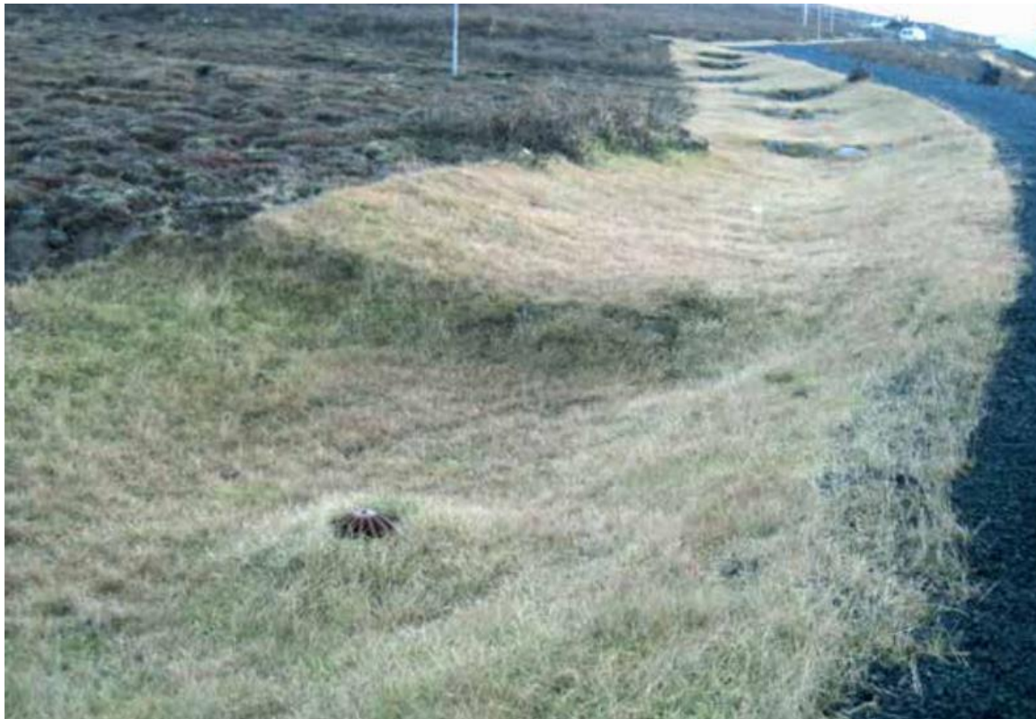
Figur 33: Grøft med terskler. Kilde: https://vannforeningen.no/wp-content/uploads/2015/06/2013_882460.pdf
