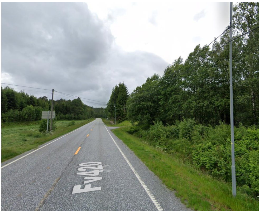
Figur 35: Utklipp fra google maps av fv.420, sør i prosjektområdet.
