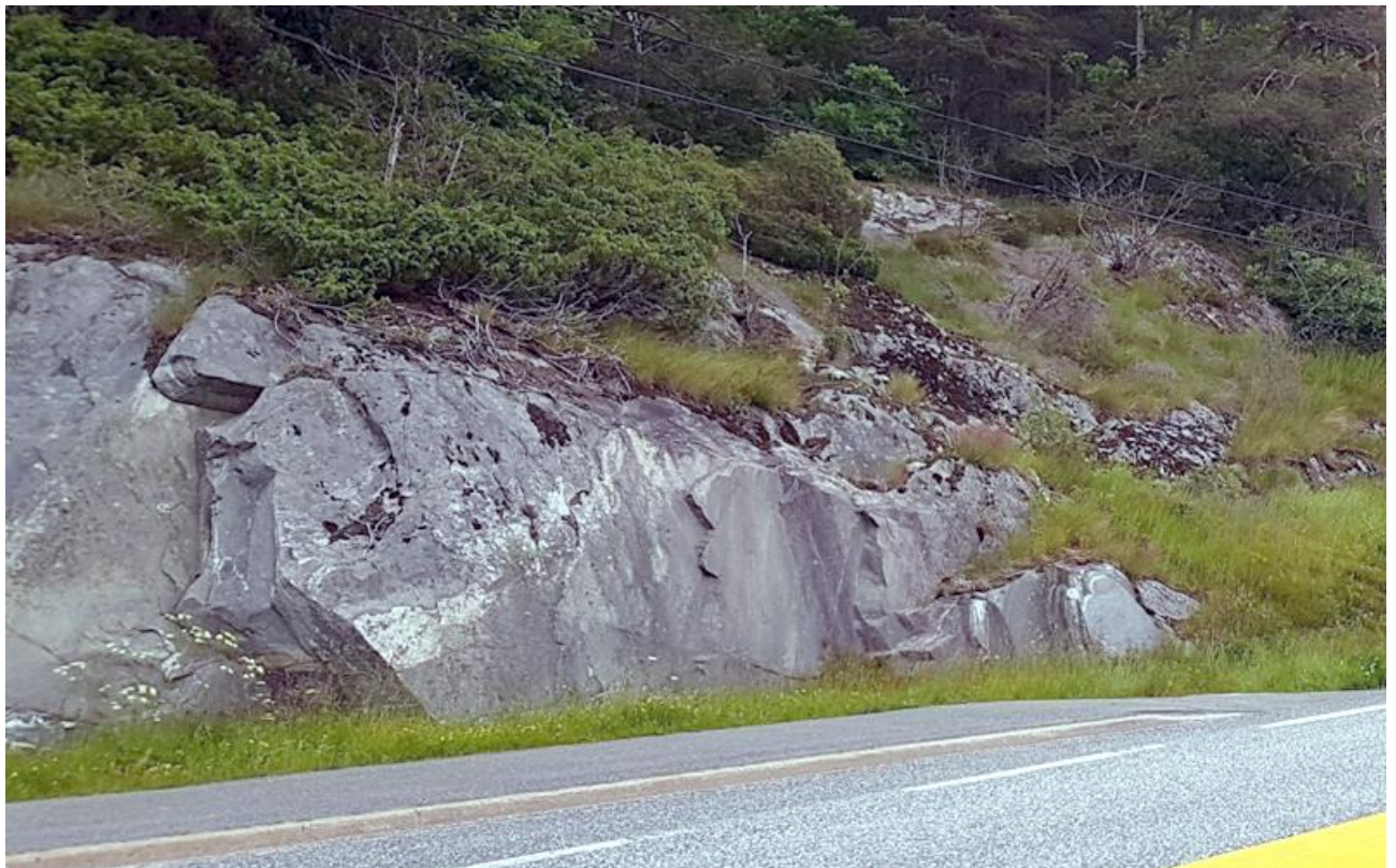
Figur 25: Veiskjæring til fv. 420 på nordre siden av veien, i nordvestenden av prosjektområdet.
