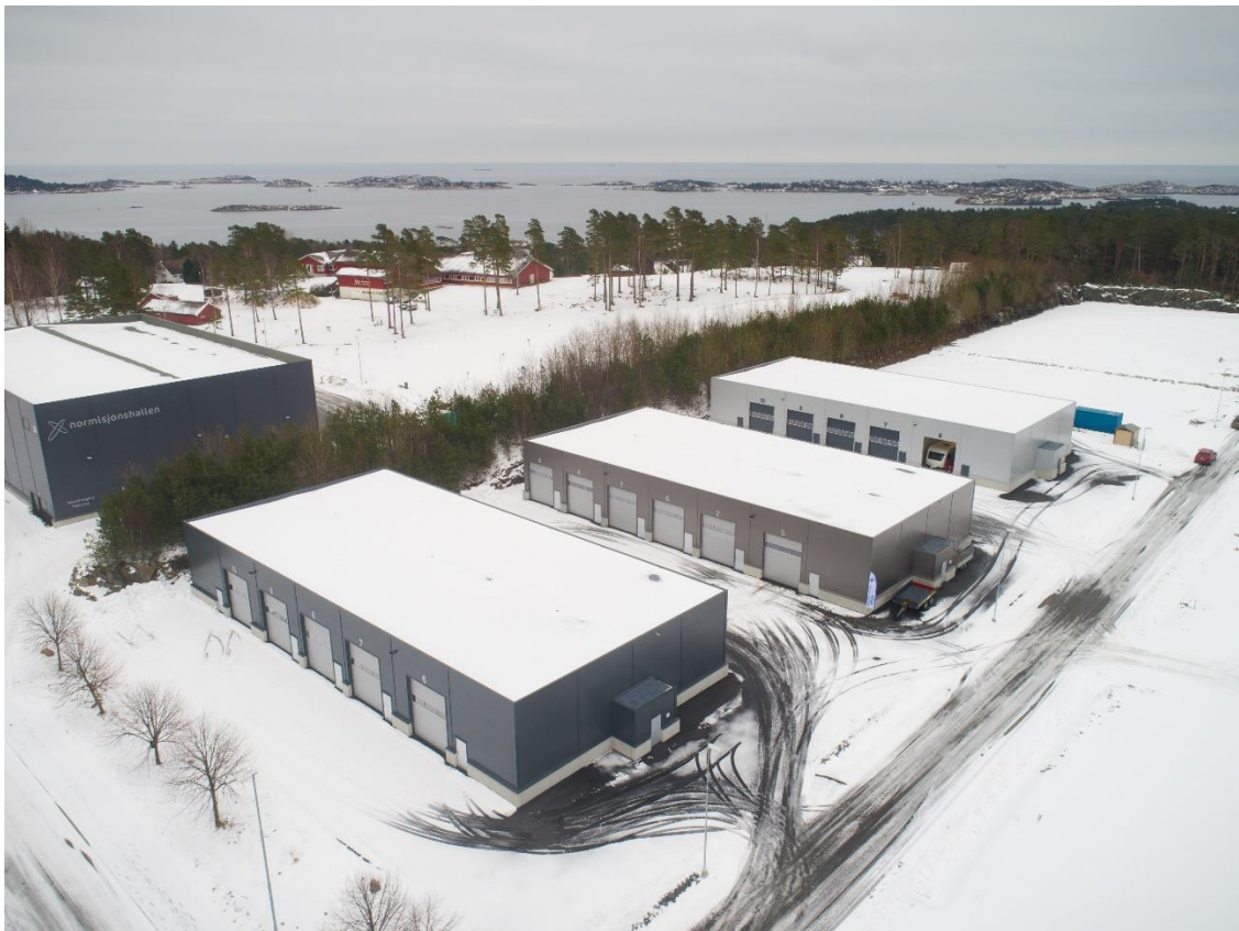
Lagerbygg oppført i 2017 i Østerskogen på den nye parsellen på Lid-tomten
