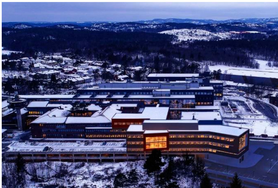
Figur 12: Bildet viser universitet i Grimstad med det nye I4 Helse bygget som er under oppføring. Bildet er tatt fra nettsiden jbu.no
