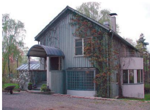
Småhus Villaveien, Oslo.
