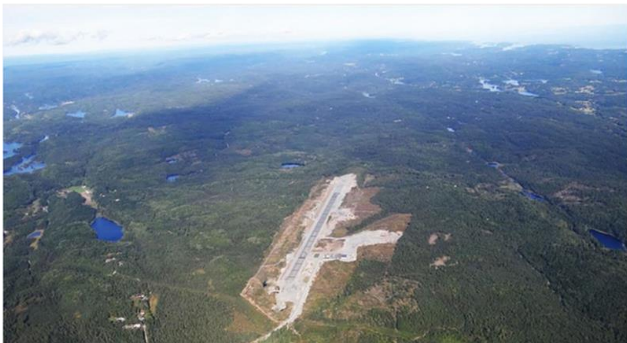
Figur 5.21 Gullknapp 2013. Anleggsarbeider pågår (foto: www.gullknapp.no )
