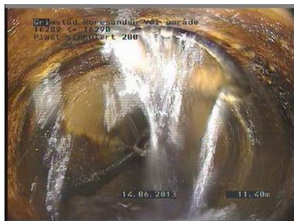
b) Innlekking av vann via forskjøvet skjõt. Mulighet for utlekking via de samme skjøter.
