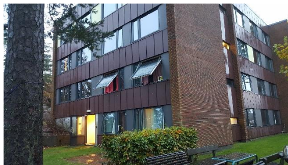
Bildene viser studentleilighet etter brann i bærbar pc under lading om natten.
