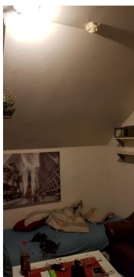
Bildet viser branntilløp seng og tildekket detektor i tak
