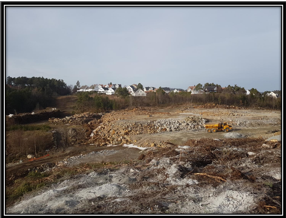
Morholtåsen – påbegynt sprengning og tilrettelegging av eneboligtomter
