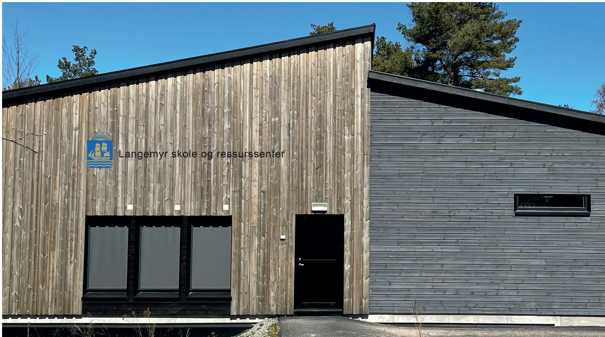
Langemyr skole Grå vegg: 8,40 meter lang. Brun vegg: 8,50 meter lang
