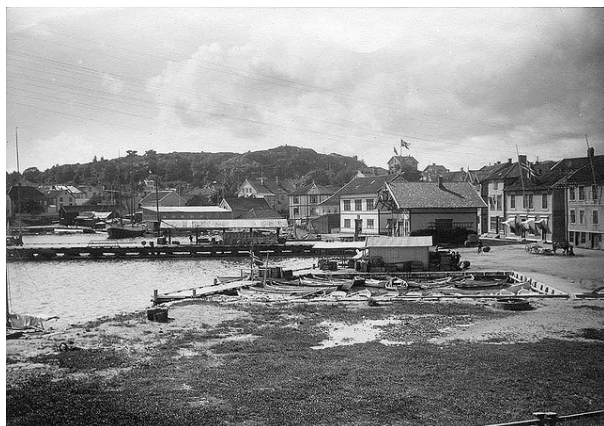
Dampskipskaia med ekspedisjonsbygg, og kun et tak over godslageret ute på brygga. Bilde Gr. Bibliotek
